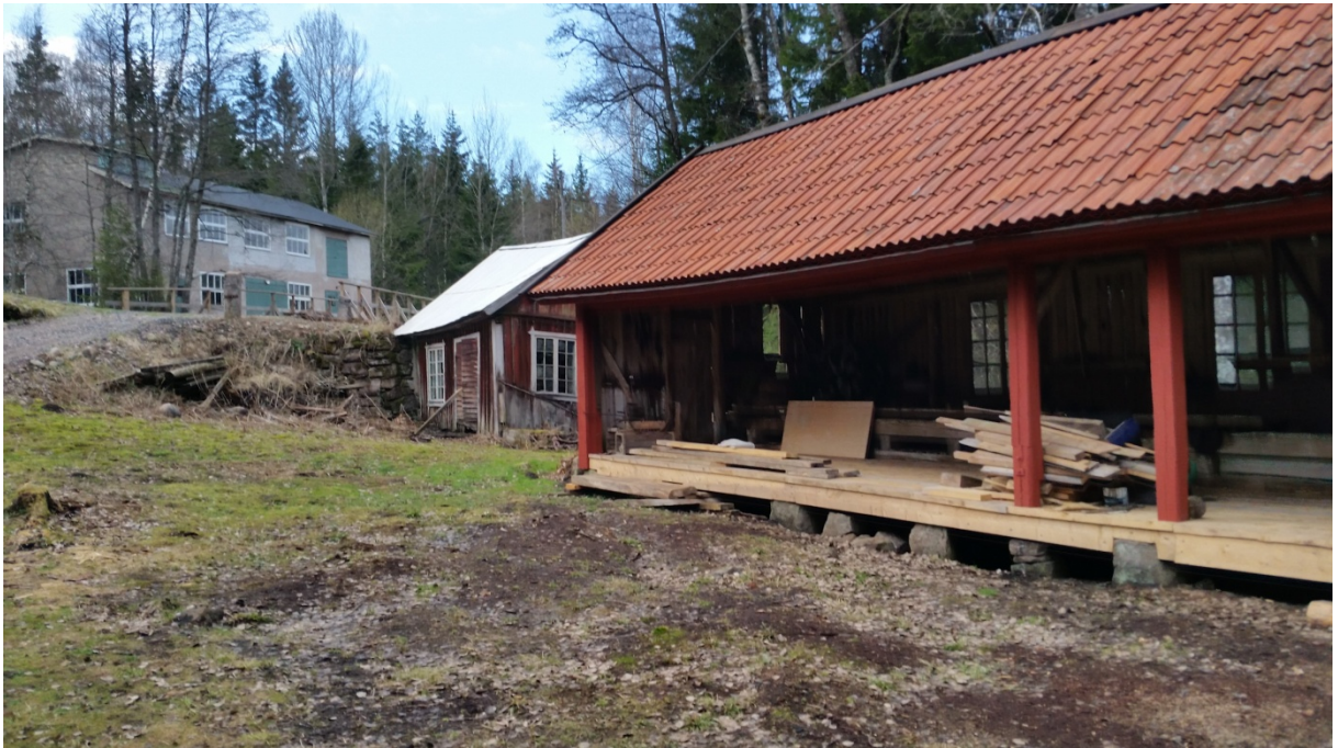
7. Snickerifabriken, elektricitetsverket och den nyrestaurerade sågen.
