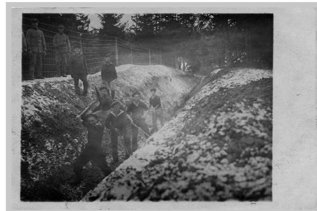
Albatrossare i arbete med att gräva ett dike på förläggningen. Att vara internerad innebar inte att man tvingades till arbete utan allt var frivilligt. Tyskarna fick också ersättning när de arbetade inom lägret eller utom detta. Bevakningsstyrkan skulle alltid utgöras av minst tio procent av arbetsstyrkan, dock som lägst två man. Äkta foto. Obegagnat.
